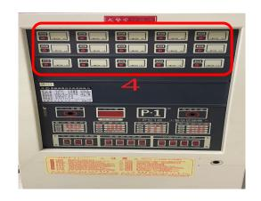
關閉受信總機主音響、地區音響、移報開關 圖1處主機音響、圖2處地區音響、圖3處移報開關
