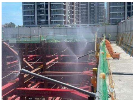
圖 4 運用灑水、水霧並可搭配鼓風機送風進行降溫
