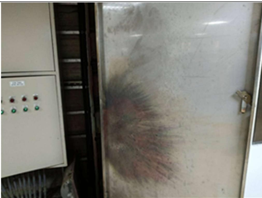
114 年商學院 9F 管道間漏水造成低壓匯流排爆炸
